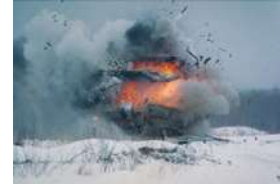
Железобетонное сооружение в момент поражения
